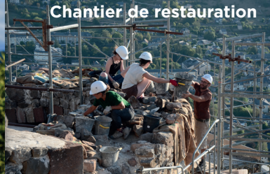
Chantier de restauration
